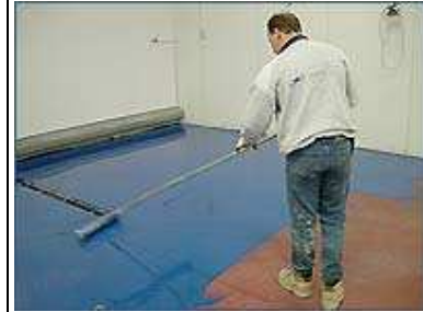
Aanbrengen vloercoating
